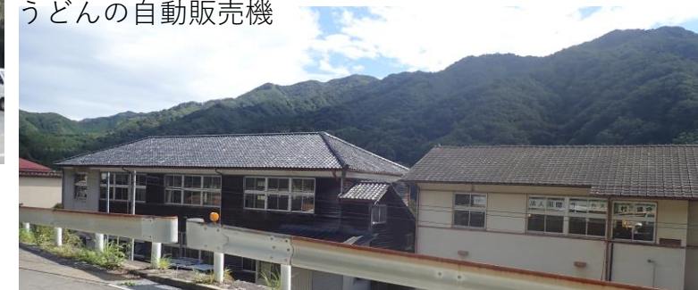
小学校の木造校舎
